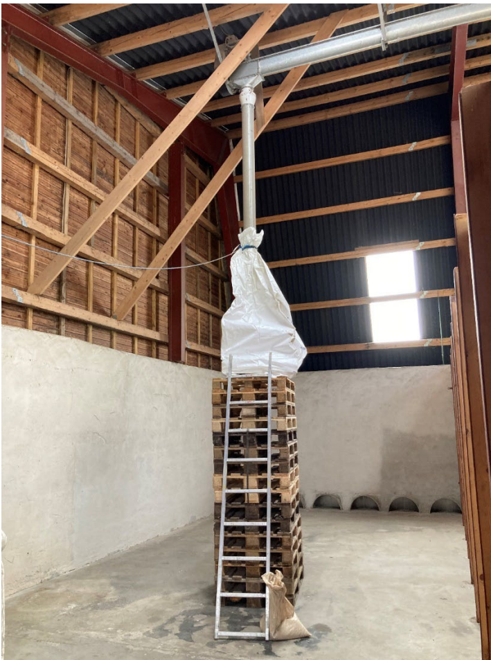
Foto 5: Efter rensning af siloer og transportanlæg, vil en god procedure med at lade et par hundrede kilo afgrøde "skylle" anlægget igennem. "Skylleafgrøden" afsættes til anden side og vil være med til at minimere risikoen for glutenholdige kerner i afgrøden. Fotograf Lars Egelund Olsen, Innovationscenter for Økologisk Landbrug.
