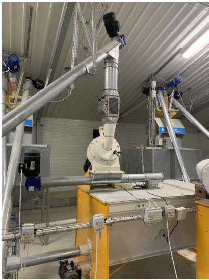
Billede 2: Foderrummet hos Øko-Ægget, hus 15 og 16
