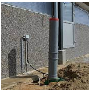
Der kan monteres automatisk åbning af ventiler til rørudslusningsanlægget. Daglig udslusning kan praktiseres med et linespilsanlæg. Kilde: Agrifarm
