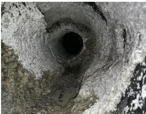
Billede 1: Uønsket udfældning af struvit i spildevandsrør. Foto: Peter Balslev, KRÜGER A/S
