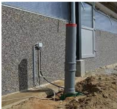
Figur 4: I forbindelse med etablering af gylleudslusningsanlæg kan der monteres automatisk åbning af ventiler til rørudslusningsanlægget. Daglig udslusning af gyllen kan praktiseres med et linespilsanlæg. Foto: Agrifarm
