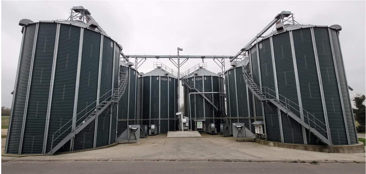
Billede 15. Udendørs silobatteri med 6 stk. 330 m 3 tørresiloer med omrøring. Foto. Jens Erik Iversen, SUKUP Europe.
