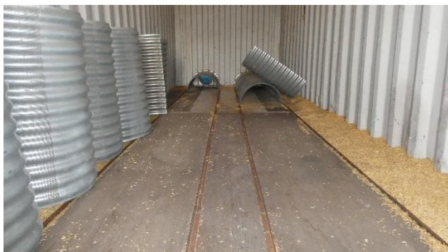
Billede 11. Rundbuer placeres mellem styreskinner i bunden. Fotos: Henning Sjørslev Lyngvig, SEGES
